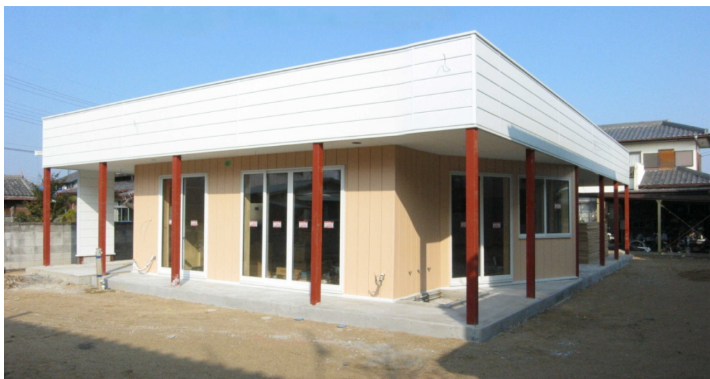
建設中の「たけのこ保育園」
